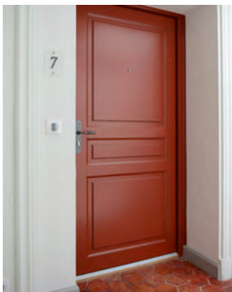
Porte palière moulurée et sécurisée
