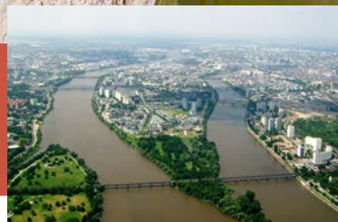
L'île de Nantes en rénovation jusqu'en 2030
